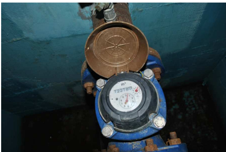
Figura 31 Dettaglio contatore sulla condotta di alimentazione di Corliod
