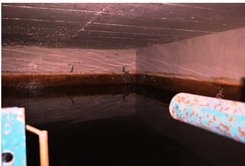
Figura 8 Interno vasca con visibili screpolature e lacune nel trattamento superficiale
