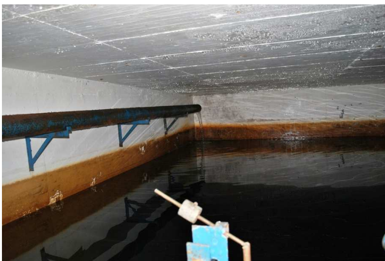
Figura 10 Interno vasca con tubo di adduzione
