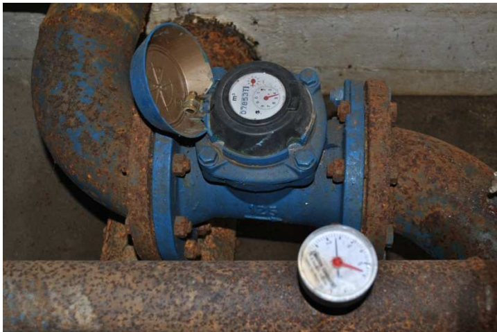
Figura 12 Dettaglio contatore sull'alimentazione vasca da Moussanet
