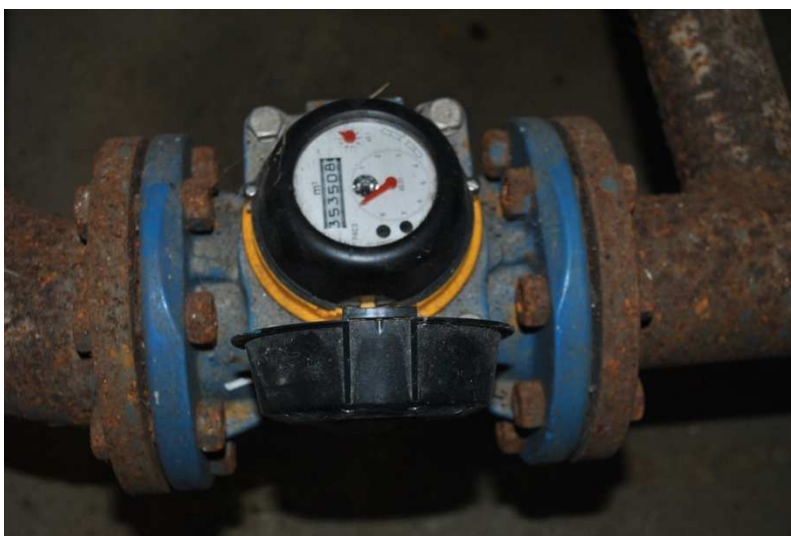
Figura 11 Dettaglio contatore di alimentazione Tilly
