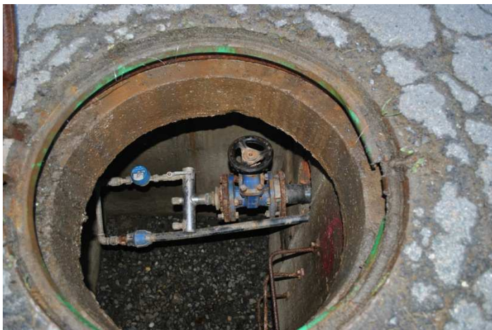
Figura 35 Interno del pozzetto di fine linea sulla strada per Chatillonet da collegare alla vasca
