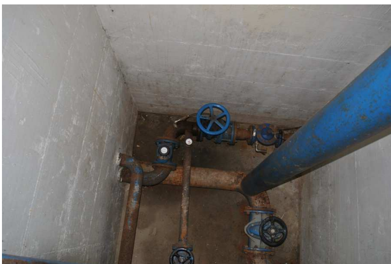
Figura 7 Dettagli camera di manovra con verniciature da mantenere
