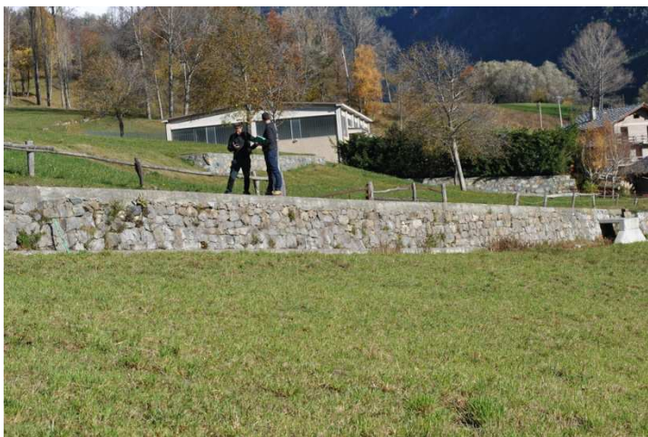
Figura 24 Vista da valle del muro di sostegno della strada per Chatillonet da sottopassare con la nuova condotta
