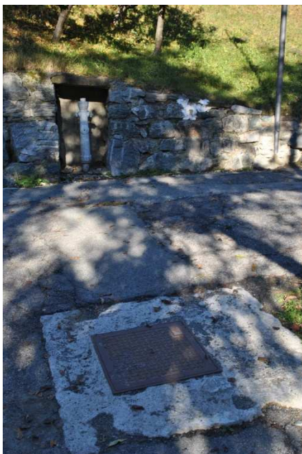
Figura 3-Plesod pozzetto di fine linea e idrante da sostituire
